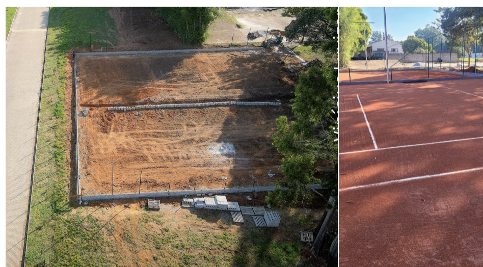
Obras das novas quadras foram bem planejadas
