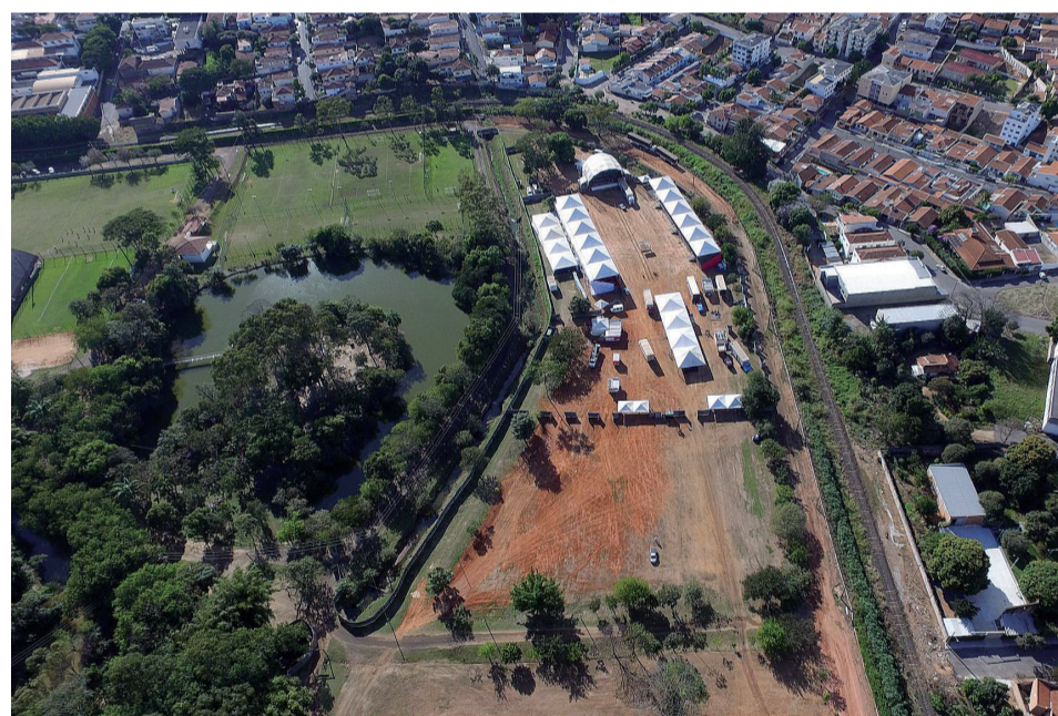
Em 2016, instalações elétricas já existiam no mesmo local, que recebeu alvará
